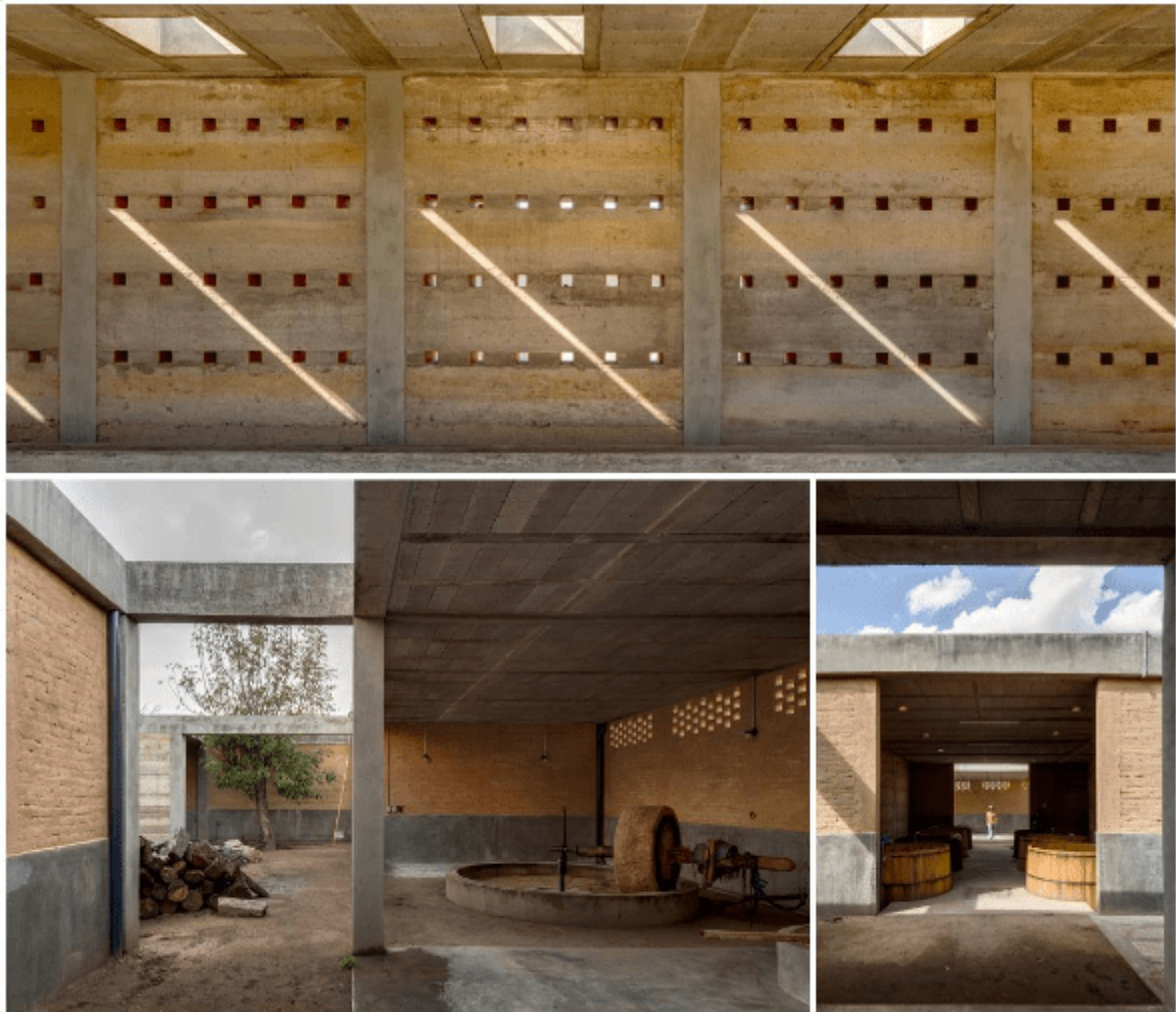
Imagen 14. Conjunto fotográfico de la Industria Palenque. Tomada de Plataforma Arquitectura [Portal web] (2018), p. s/n.
