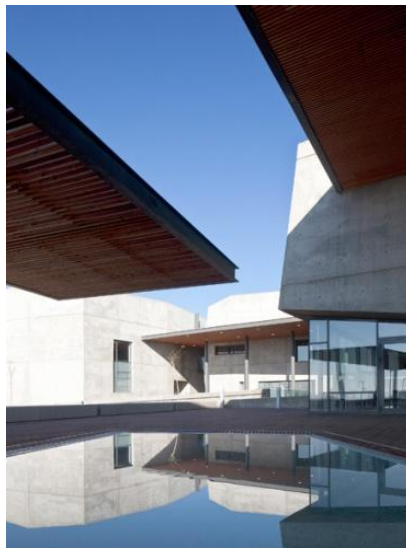
Gráfica12. Centro de rehabilitación Beit Halojem Fuente: Plataformaarquitectura.com
