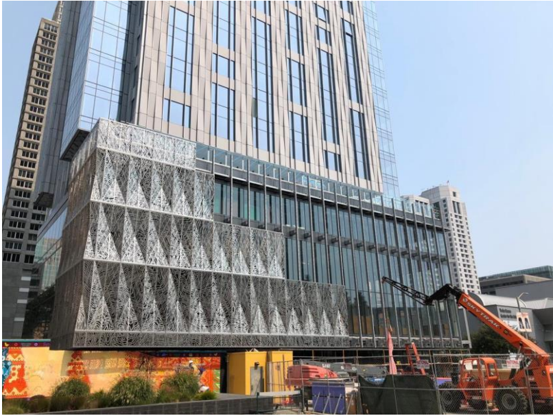
Figura 7: Mexican Museum. San Francisco, CA, USA. Fuente: TEN Arquitectos (2020)
