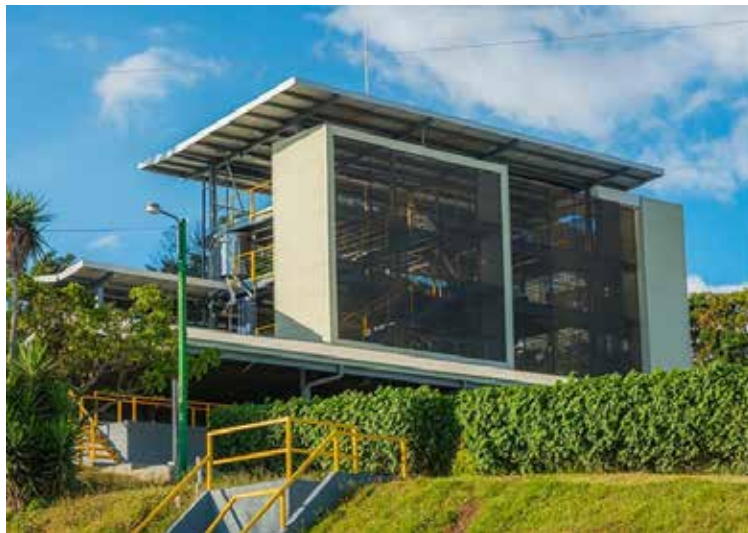
Figura 2. Área de Maquinaria de la Hacienda Alsacia Starbucks Coffee Company. Fuente: https://nemvo.com/articulos/arquitectura/hacienda-alsacia-se-renueva-para-traer-la-mejor-experiencia-starbucks/ (2018)
