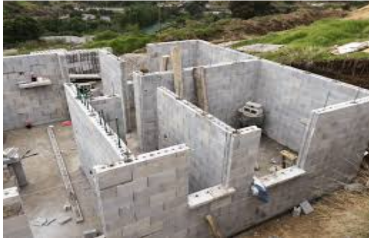
Figura: Procesos de instalación con Bloques ARMO.
