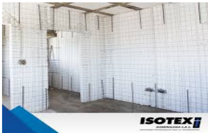
Figura: Mpanel instalado.
