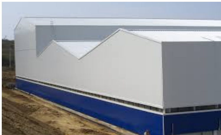
Figura: Construcción terminada con TermoLosa C.
