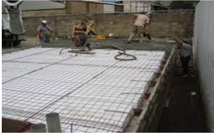
Figura: TermoLosa instalada en obra.
