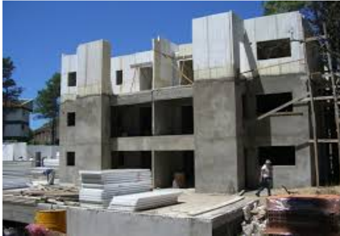
Figura: Construcción con Mpanel con friso.
