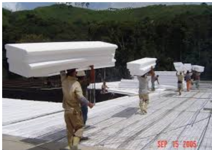
Figura: Traslado de TermoLosa C.
