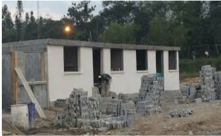
Figura: Casa en construcción con Bloques ARMO.
