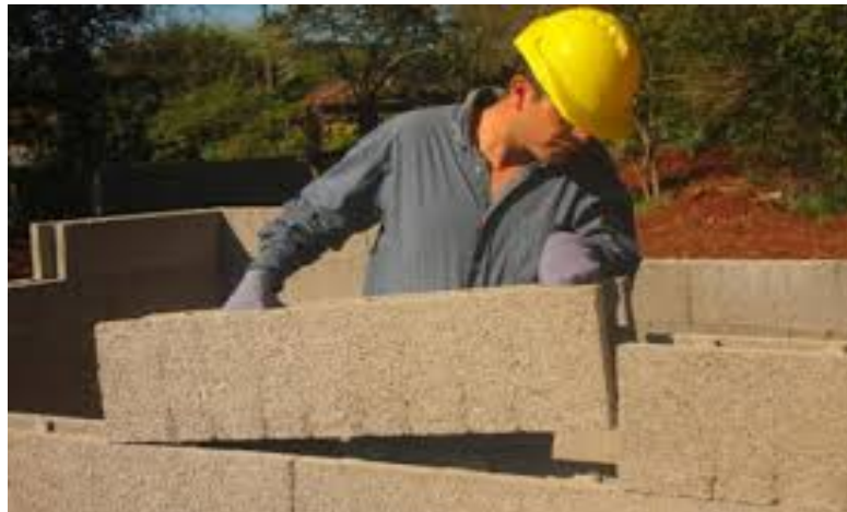
Figura: Instalación de bloques de concreto con aserrín.
