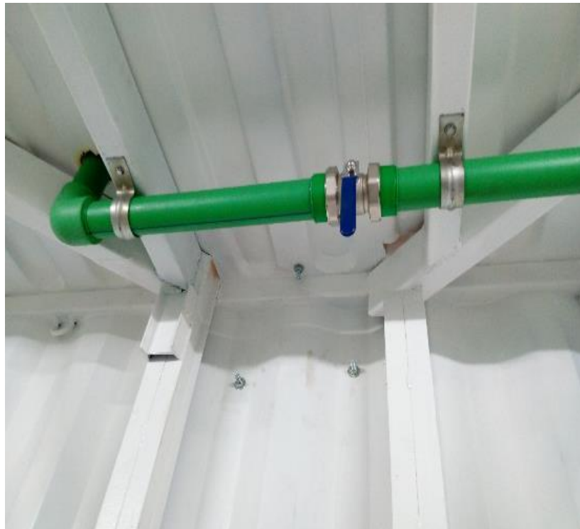
Figura 52: Instalación de tubería de llenado.
