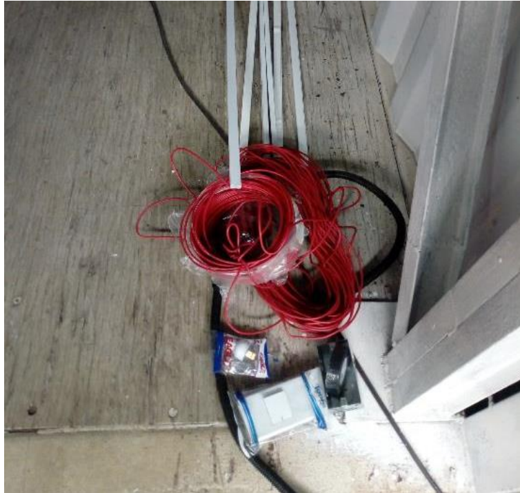
Figura 51: Materiales para instalación eléctrica de contenedor N°1.
