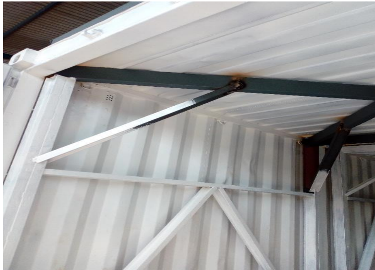
Figura 44: Estructuras mientras se pintan.
