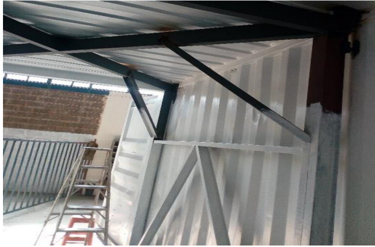
Figura 45: Estructuras mientras se pintan.
