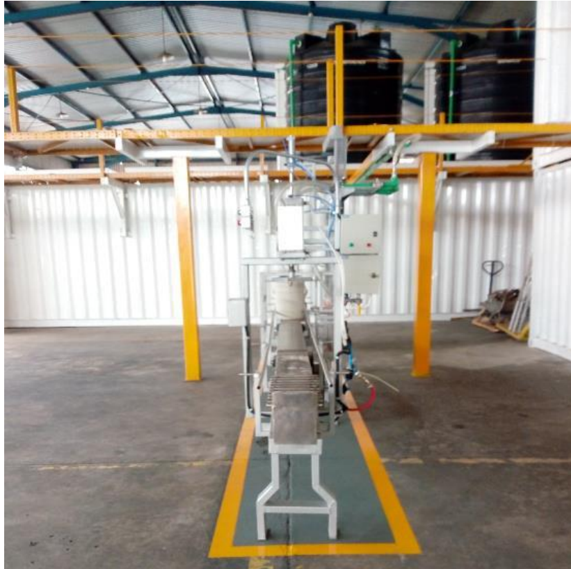
Figura 55: Tuberías de llenado y descarga.
