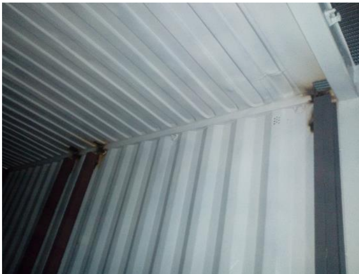
Figura 43: Tubo estructural soldado.
