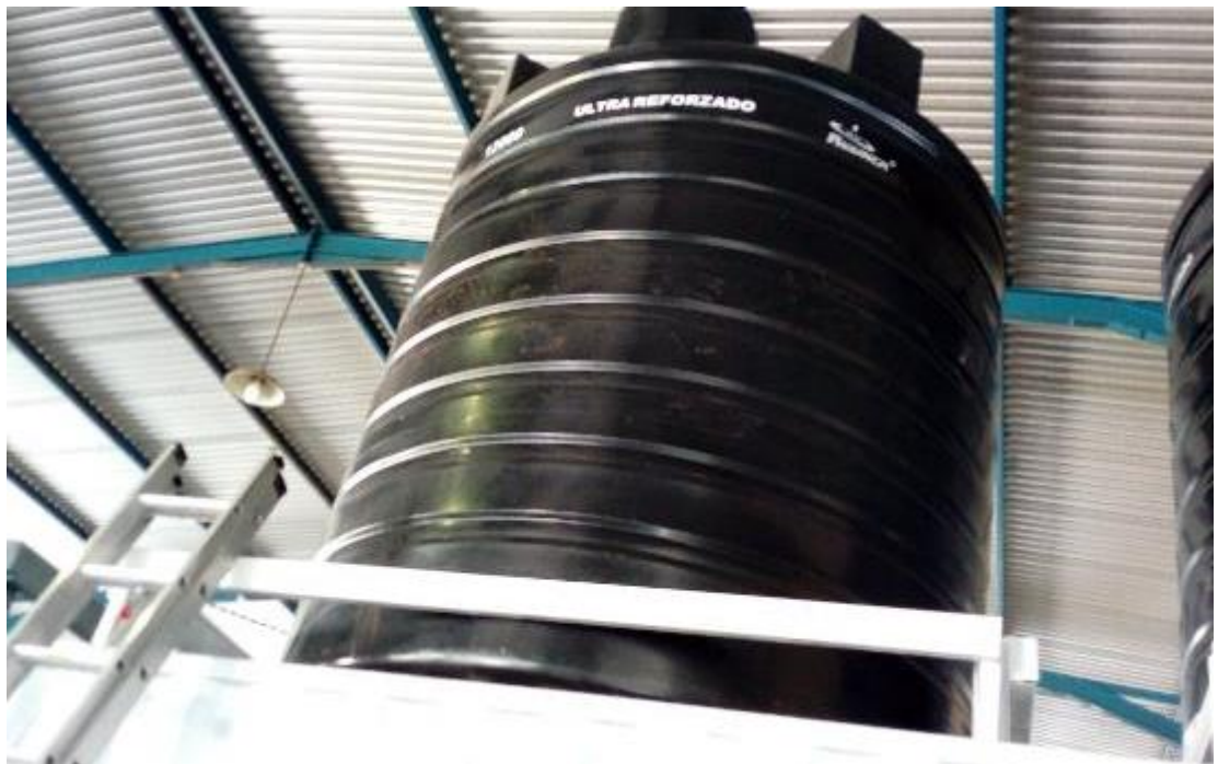
Figura 47: Estructuras pintadas base tanques.
