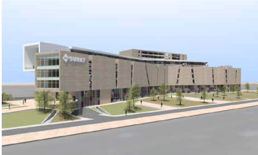
Figura 5: Edificio Quipu (Nueva Sede Central Sunat). (2009)
