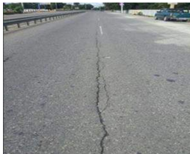
Figura 16. Grieta Longitudinal.
