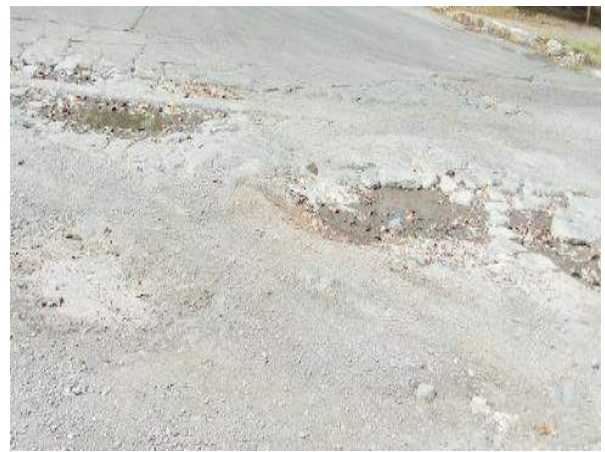
Hueco y Disgregación Durán y Rondón (2023)
