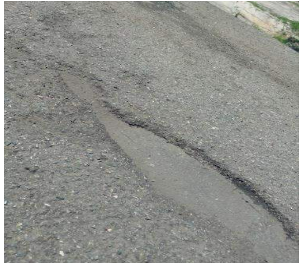
Hueco y Disgregación Durán y Rondón (2023)
