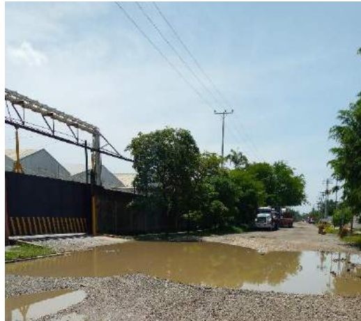
Figura 3. Estancamiento de agua por falta de sumideros.
