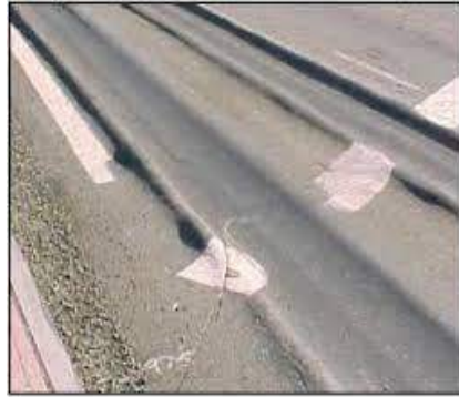
Figura 10. Elevación- Hundimiento.
