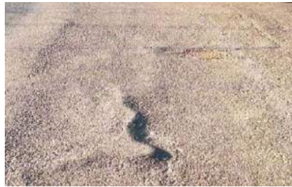
Figura 23. Deformación por empuje.
