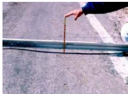
Figura 22. Ahuellamiento.
