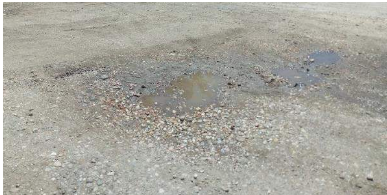
Hueco y disgregación Durán y Rondón (2023)
