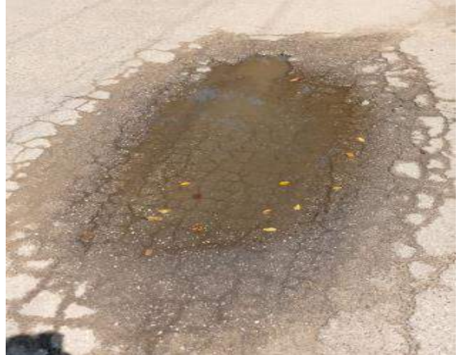
Hundimiento y Piel de cocodrilo Durán y Rondón (2023)
