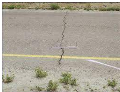
Figura 17. Grieta Transversal.
