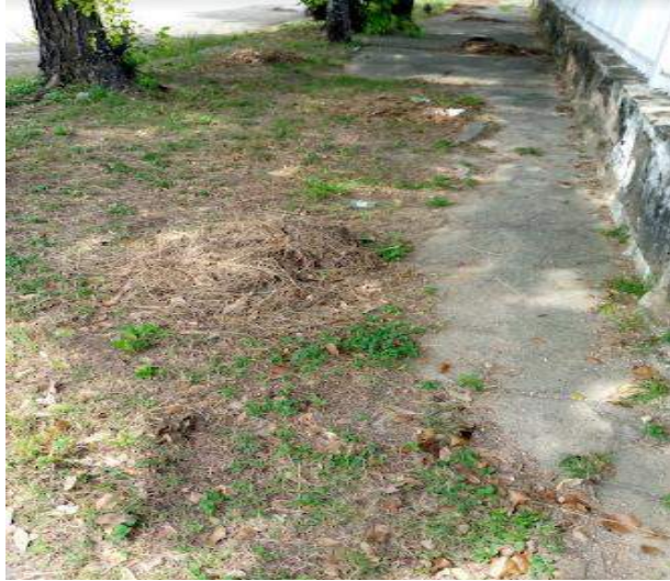
Figura 35. Falta de mantenimiento en acera Autores: Durán y Rondón (2023)
