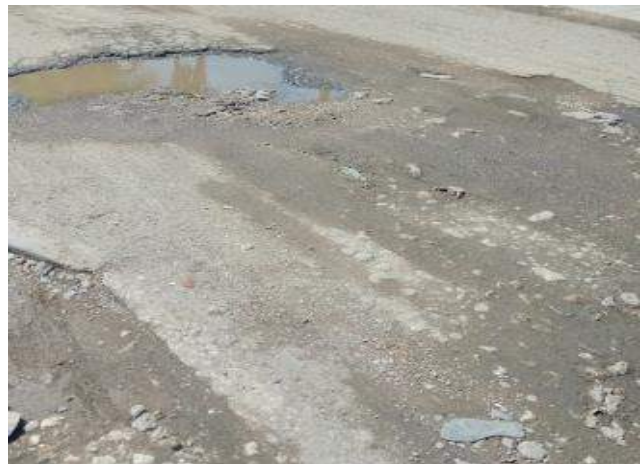
Hueco y Disgregación de material Durán y Rondón (2023)
