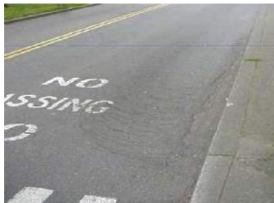
Figura 24. Desplazamientos.
