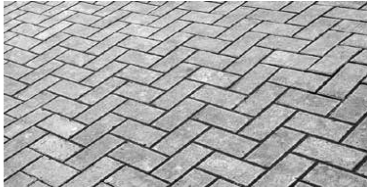
Acabados de pisos de Parque – Adoquín Calado.
