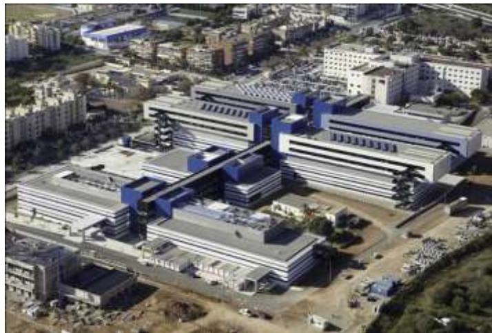
Figura 2: Vista Hospital Can Misses en Ibiza, España. Fuente: www.plataformaarquitectura.cl (2015)
