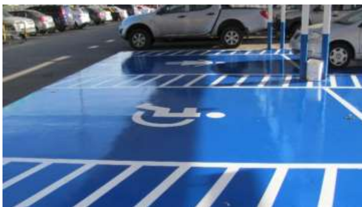
Figura 87: Pintura Epóxica en Estacionamiento Fuente: www.concretal.cl (2012)
