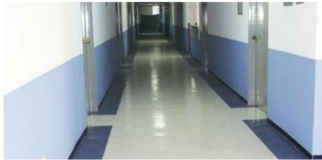
Figura 94: Piso de Vinil en Hospital Fuente: www.vinisol.com.co (2017)
