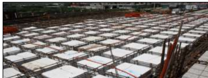
Figura 78. Losas de entrepisos. Fuente: El Autor (2022)
