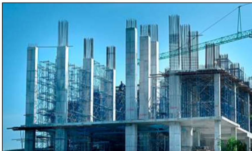
Figura 72. Estructura de concreto armado. Fuente: El Autor (2022)
