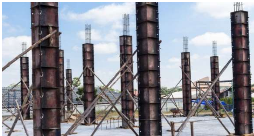
Figura 75. Columnas. Fuente: El Autor (2022)
