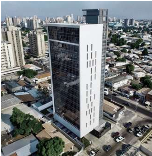
Figura 6 Fachada de la Torre 13 / Mat-la Fuente: Fernández, Casarin, Ball (2016)
