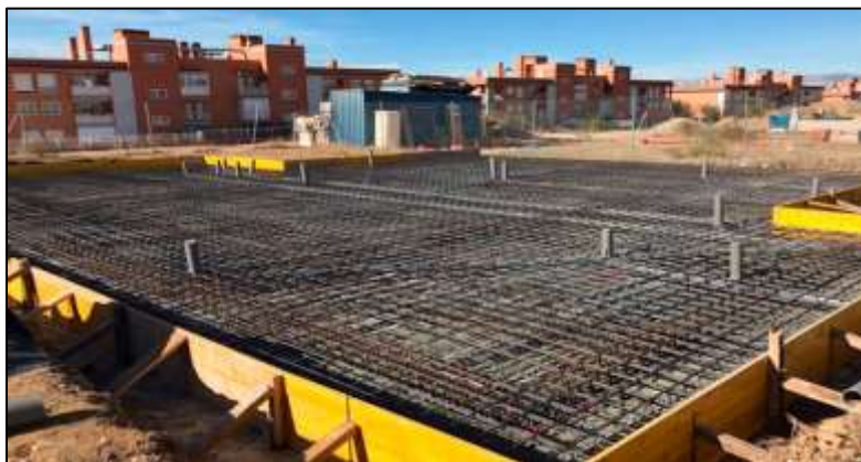
Figura 74. Losas de piso. Fuente: El Autor (2022)
