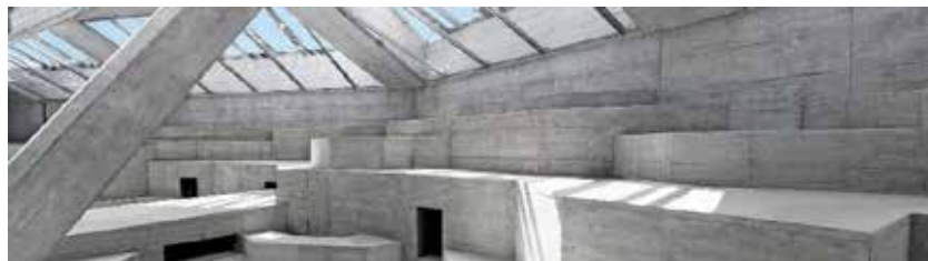
Figura 64. Concreto a Obra Limpia
