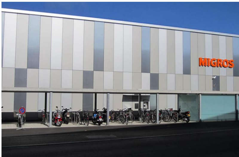
Figura 34. Revestimiento en fachada con Alecubond. Fuente: http://img.archiexpo.es/images_ae/photo-g/1616-9450956.jpg (2018)
