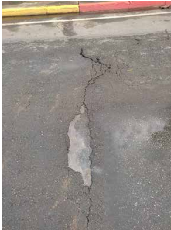
Figura 51: Grieta Longitudinal
