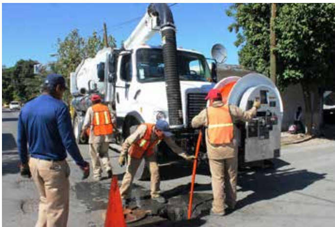
Figura 108: Mantenimiento de elementos hidráulicos.
