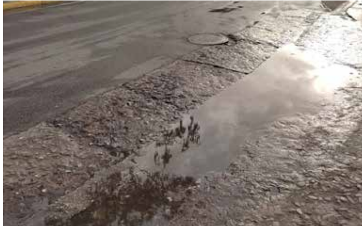
Figura 54: Hundimiento
