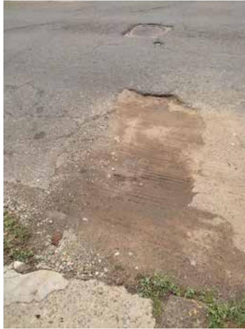
Figura 59: Hundimiento.
