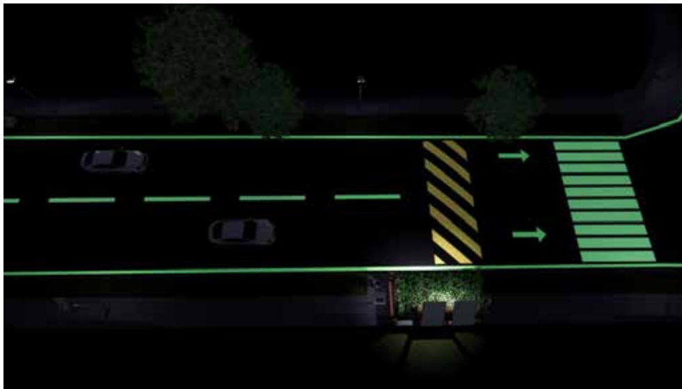
Figura 122: Demarcación con pintura fotoluminiscente.
