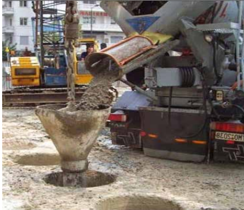
Figura 4. Vaciado con tubería tremie
