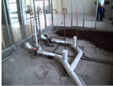
Gráfico 36: Modelo de instalación de aguas negras
