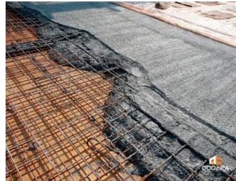
Gráfico 33: Losa de concreto armado maciza.
