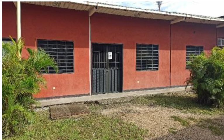
Figura 7. Área de Almacén (Parte exterior). Fuente: Castillo E. (2020)
