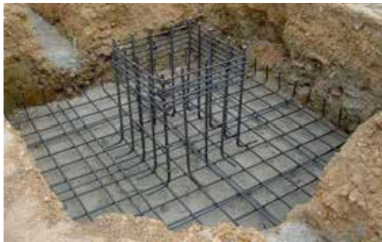
Figura 2. Fundación aislada. Nota.
