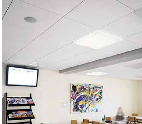
Figura 40: Techos de Drywall en salones de clases . Fuente: http://www.archiexpo.es/fabricante-arquitectura-design/falso-techo-540.htm
