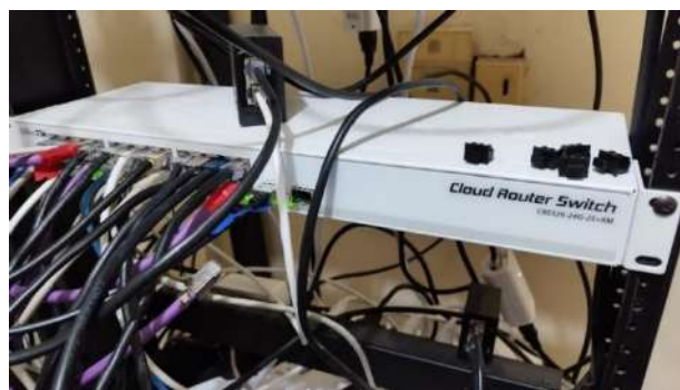
Figura 20. Switch de la celda, marca Microtik, modelo CRS326-24G-2S+RM.
